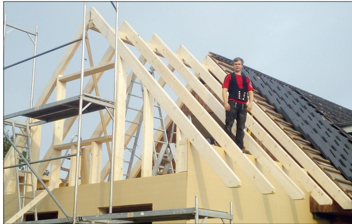
Ein fertiggestellter Dachstuhl - eine der vielen Arbeiten, die die Timmendorfer Zimmerei fachgerecht in echter Handwerkskunst durchführt.
