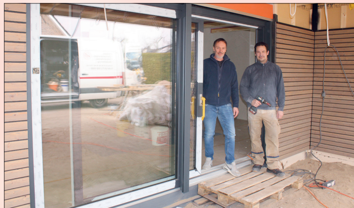
Firmenchef Timm Boekhoff (li.) mit Alt-Geselle Dennis Buchwald beim Einbau von hochwertigen Schiebetüren, Fenstern und Haustüren.
