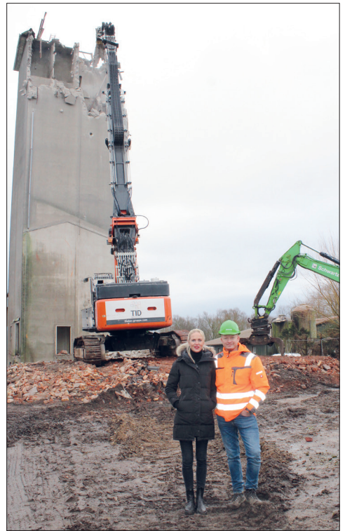
Das Unternehmer-Ehepaar Alexander und Nina Schwartz vor dem im Abriss befindlichen Getreidesilo.
