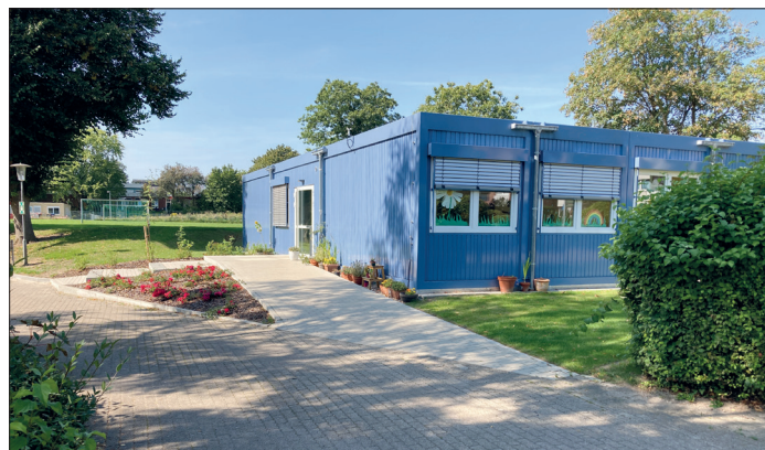
Aufgrund der gestiegenen Schüler- und Mitarbeiterzahlen mussten an zwei der drei Stockelsdorfer Grundschulen Container aufgestellt werden. Das Land fördert diese Maßnahme mit einer beträchtlichen Summe. Foto: Gemeinde Stockelsdorf
