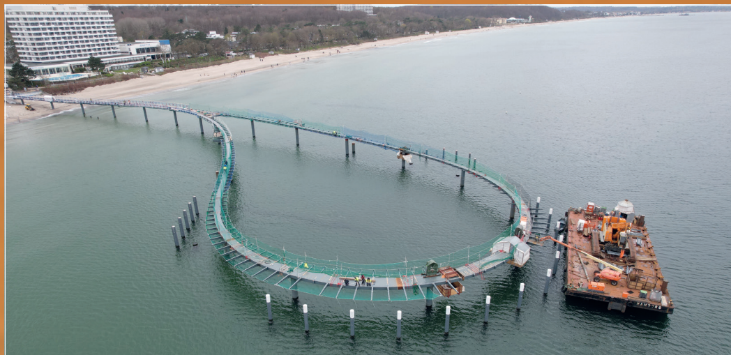
Am 27. März 2024 erfolgte der Lückenschluss der 427 Meter langen Seebrücke in Timmendorfer Strand, als das letzte Brückensegment seeseitig eingesetzt wurde. (Foto: L+W/Stoll)
