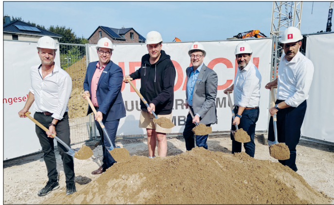
Symbolischer Spatenstich mit Matthias Langhans (Projektleiter Theo Urbach GmbH, von links), Simon Lorenz (Filialleiter Sparkasse Holstein), Thies Klatt (Geschäftsführer Theo Urbach GmbH), Bürgermeister Sven Partheil-Böhnke, Markus Habermann (Geschäftsführer SIG Holstein) und Thomas Bothe (Generalbevollmächtigter der Sparkasse Holstein).
