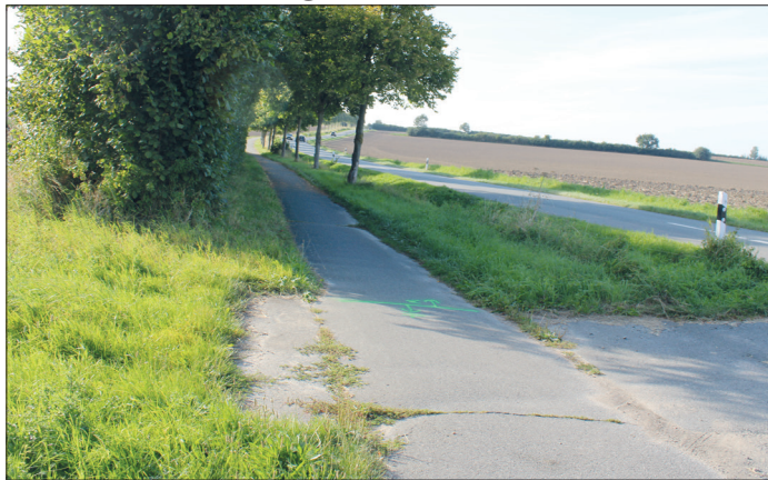
Darauf haben viele lange gewartet. Ab Montag wird mit der Erneuerung des Radwegs zwischen Pohnsdorf und Bad Schwartau begonnen.
