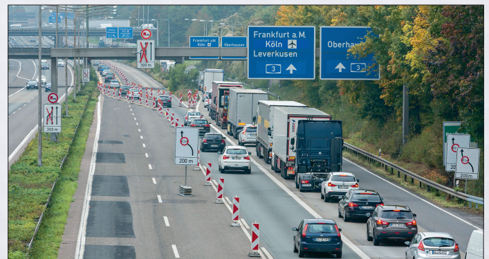
In Baustellenbereichen ist die rechte Fahrspur grundsätzlich breiter als die linke. Werkfoto: ADAC
