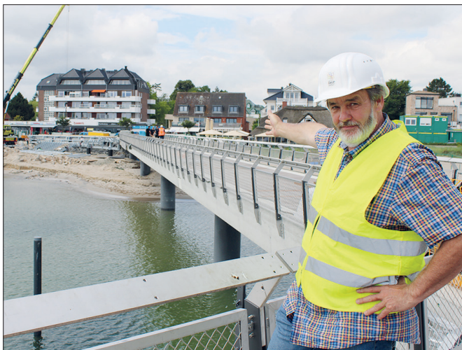
Bauoberleiter Matthias Franke vom Planungsbüro SWUP GmbH Berlin zeigt auf die entstehende Treppenanlage/Tribüne am Seebrückenvorplatz in Haffkrug.
