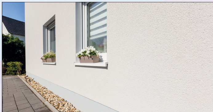
Moderne Fassadenputze mit der AquaBalance-Technologie trocknen sehr schnell und entziehen Algen so die Grundlage. So wird die Fassade vor lästigem Bewuchs geschützt - ganz ohne den Einsatz umweltschädlicher Biozide. (Foto: Saint-Gobain Weber/txn)
