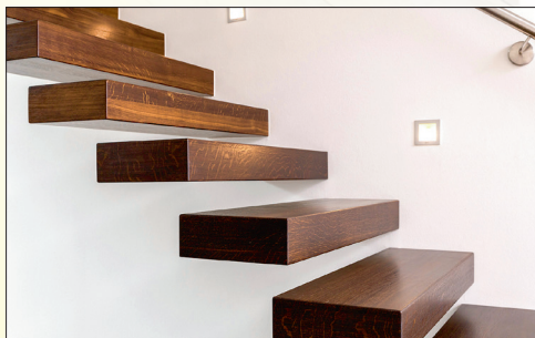
Die 110 Millimeter starken Trittstufen der Treppe bestehen aus riegelverleimtem Eichenholz. Werkfoto: Streger
