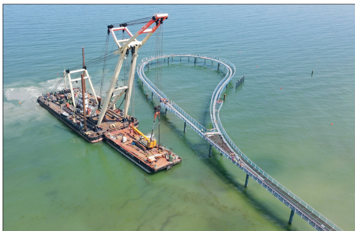
Mit dem havarierten Ponton am Haken wird der Schwimmkran „Enak“ nach Neustadt geschleppt. (Fotos: Gemeinde Timmendorfer Strand)
