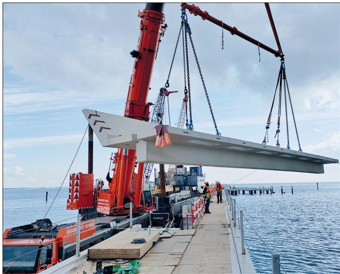
Das erste 45 Tonnen schwere Stahlbetonfertigteile der nördlichen Balkone schwebt über der Scharbeutzer Seebrücke.
