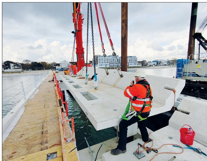
Mit einem 700-Tonnen-Mobilkran werden die Balkenteile millimetergenau in den Neubau der Scharbeutzer Seebrücke eingesetzt.
