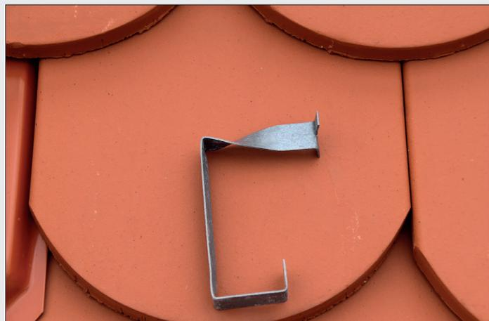
Die inzwischen vorgeschriebene Windsogsicherung – meist mit Sturmklammern – kann vom Dachdecker auch nachgerüstet werden.
