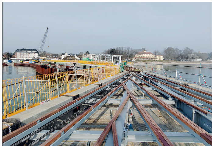
Der Blick vom zukünftigen Brückenkopf auf Haffkrug, die untere Etage fehlt noch.
