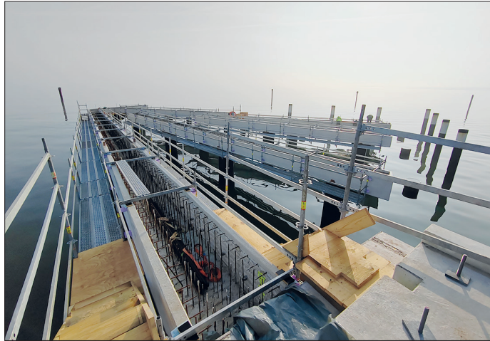
Der künftige Seebrückenkopf der Scharbeutzer Brücke ist bereits deutlich zu erkennen.
