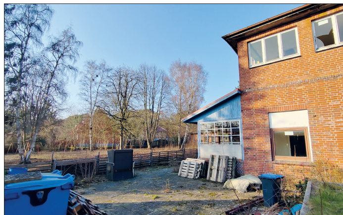
Ein Teil des 1.700 Quadratmeter großen Grundstücks zwischen Strandstraße und B 76, das voraussichtlich ab 2025 neu bebaut werden kann.
