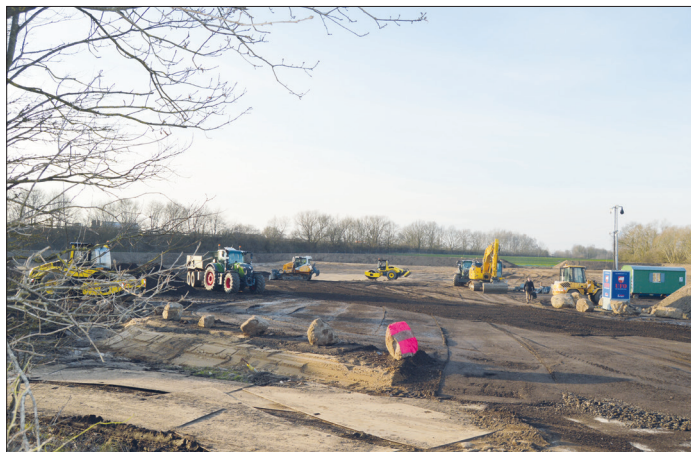
Vielen waren die „plötzlichen“ Bauarbeiten ein Rätsel. Selbst im Ratekauer Rathaus war zunächst nicht bekannt, was auf dem Acker an der A1 mit schwerem Gerät „gebaut“ wird. Jetzt ist das Geheimnis, das eigentlich nie eines war, gelüftet.
