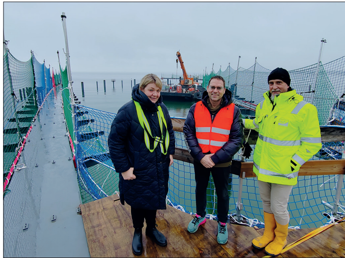
Gesine Muus, Werkleiterin des Kurbetriebes, Diplomingenieur Michael Hasselberg (Mitte) und Bauleiter Sebastian Stoll auf der Baustelle der neuen Seebrücke von Timmendorfer Strand.
