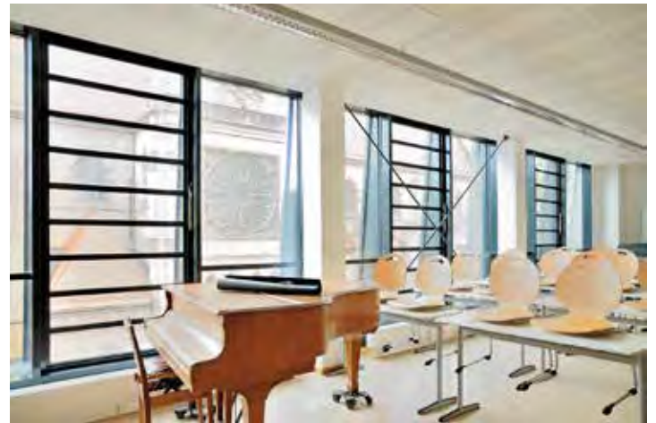
So gut kann es aussehen: Lamellenfenster in einem Schulgebäude.
