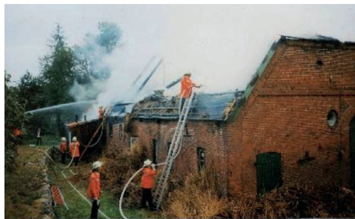
Ein verheerender Brand wütete im Sommer 1995. Dank des Einsatzes der Feuerwehr konnte so viel Bausubstanz erhalten werden, dass das Haus erneut aufgebaut werden konnte.
