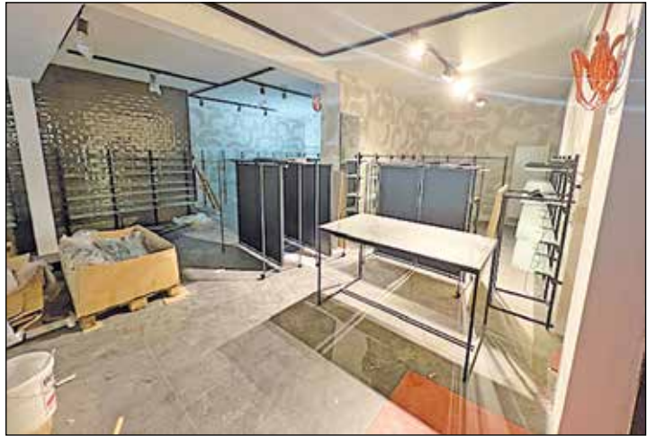
Noch 10 Tage vor Eröffnungstermin präsentierte sich das Geschäft als Baustelle... Fotos: hfr/ Selk
