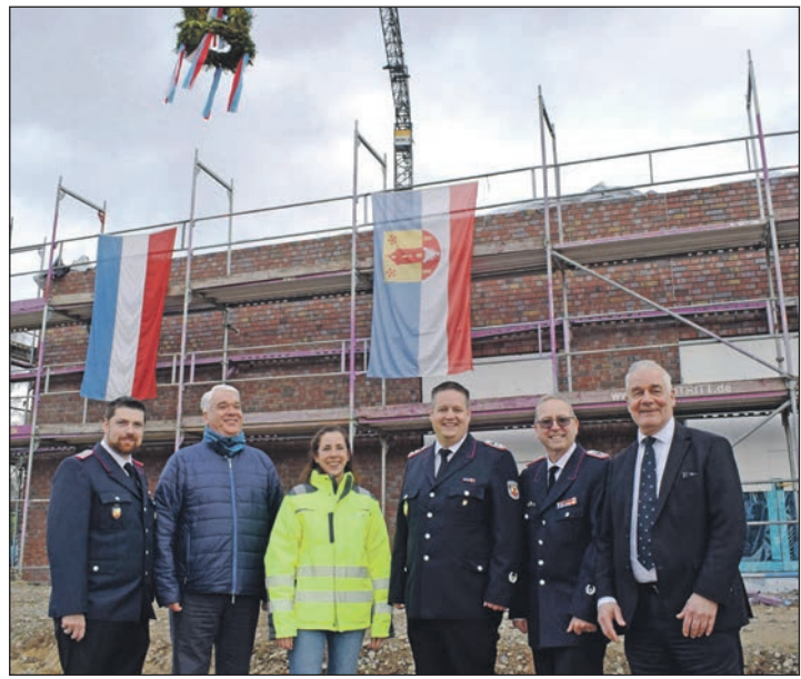
Gute Laune unter der Richtkrone: (V. l.) Gemeindeführer Moritz Otto, Bürgervorsteher Thorsten Stich, Bauleiterin Naiara Iturbe (B2K), Ortswehrführer Björn Grun und Stellvertretender Wehrführer Kai-Uwe Hartmann, Bürgermeister Gerd Radisch. Foto: © CK
