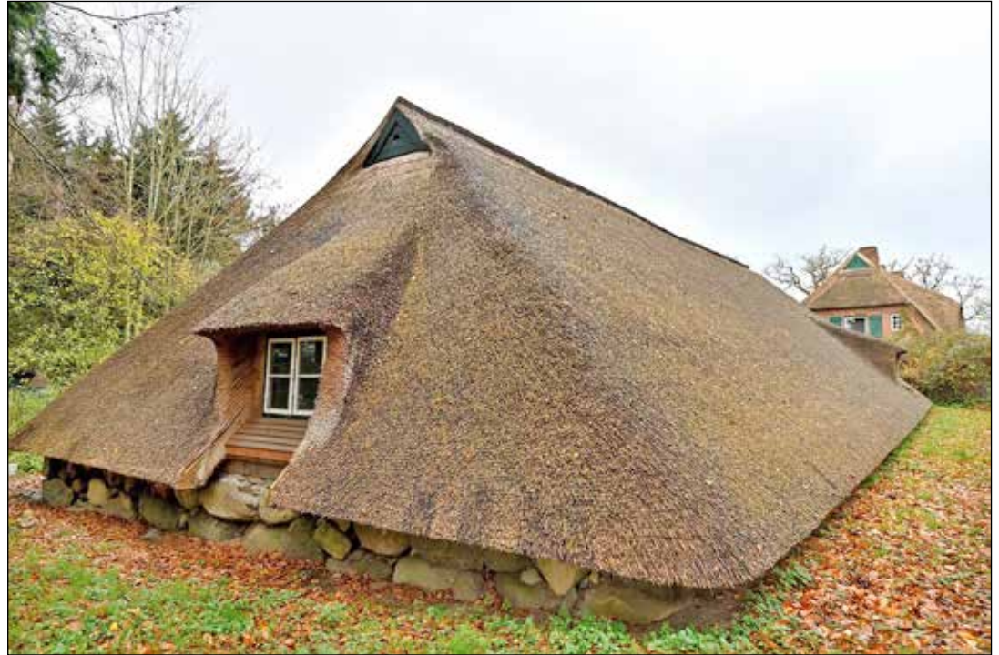
Das tiefgezogene Dach ist die bauliche Besonderheit des Schafstalls aus dem 19. Jahrhundert. In dieser Region ist er das letzte Gebäude dieses Typs.
