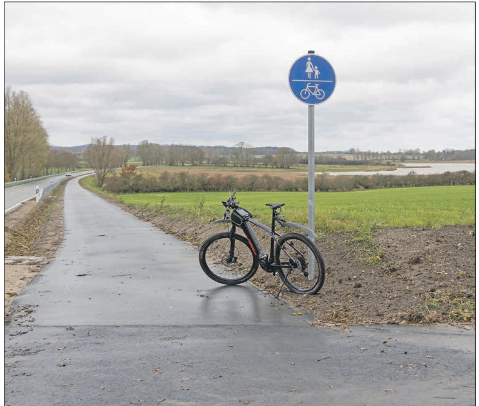
Der neue Fahrrad- und Wanderweg an der Kreisstraße 45 ist fertiggestellt. Er ist Teil des geplanten Rundwegs mit viel Erlebnispotential für Groß und Klein.
