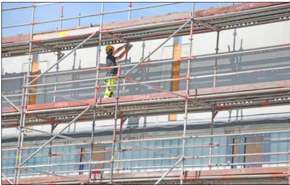
Gerüstbauer bereiten die Arbeiten an der Außenfassade vor.
