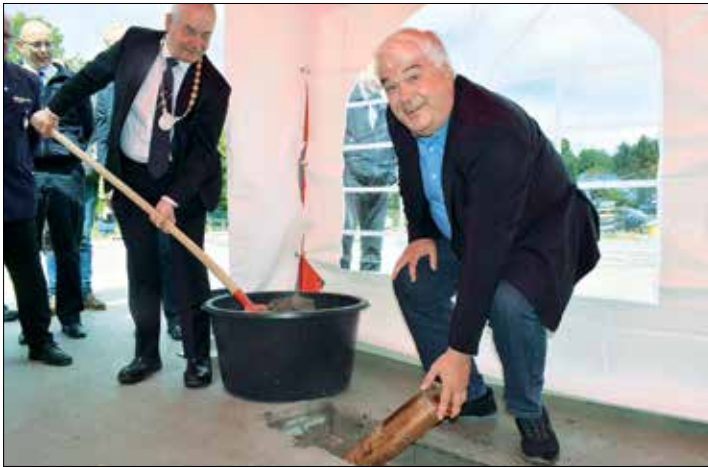
Zusammen mit Schönkirchens Bürgermeister Gerd Radisch griff Bürgervorsteher Thorsten Stich (v. l.) zu Schaufel und Maurerkelle und versenkte die Zeitkapsel im Fundament.
