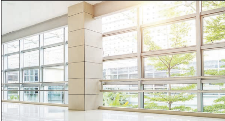
Vogelschutzglas mit Laserdruck. Auf der Oberfläche werden kleinste Punkte oder wahlweise auch Geometrien aufgebracht. Für den Menschen ist diese Veredelung kaum wahrnehmbar. Foto: hfr/HEGLA
