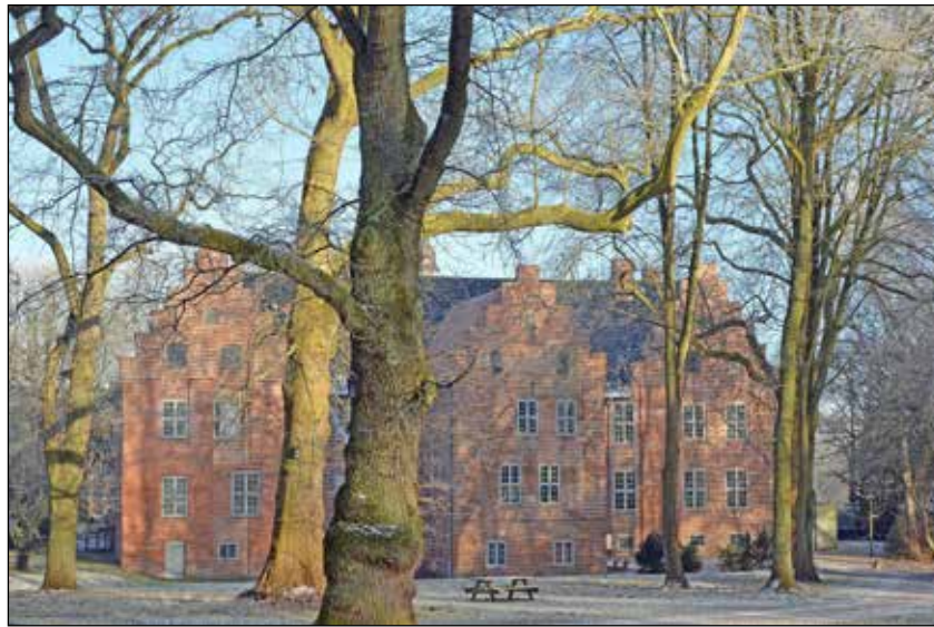
Der Förderverein Schloss Hagen lädt zu weiteren historischen Vorträgen im Kaminsaal von Herrenhaus Hagen ein. Foto: Schneider
