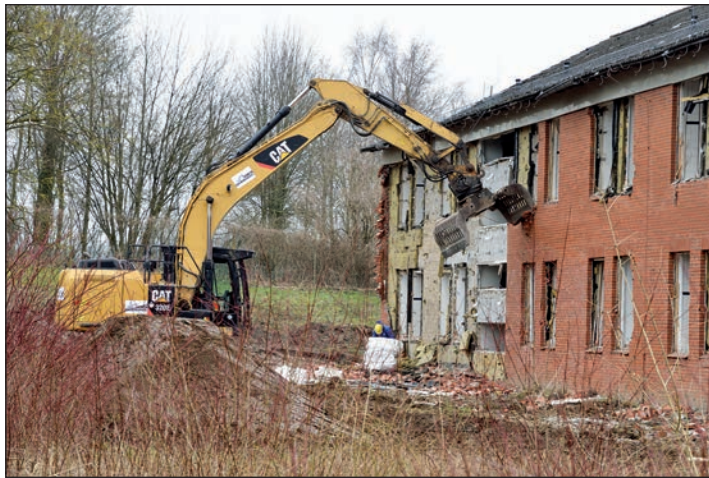
Abbrucharbeiten in der Lütjenburger Schill-Kaserne.
