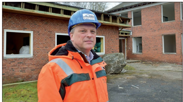
Umwandlung der Schill-Kaserne zum „Urbanen Baugebiet“: Bürgermeister Dirk Sohn gab den offiziellen Startschuss für die Abbrucharbeiten.
