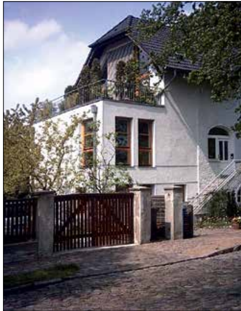
Die Frühlingszeit kann man nutzen, um Schäden am Haus zu beseitigen, die der vergangene Winter hinterlassen hat.
