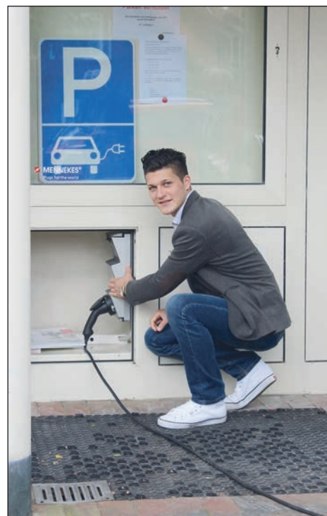
Christoph Hengelhaupt steht zu jeder Zeit bereit, um den Anschluss der Ladestation zu öffnen.
