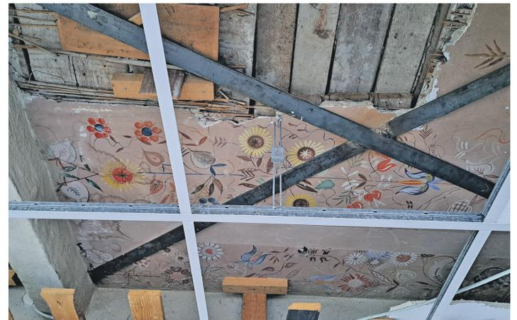
Unter der abgehängten Decke finden sich noch Spuren der ursprünglichen, mit Blumenmustern bemalten Strohecke.
