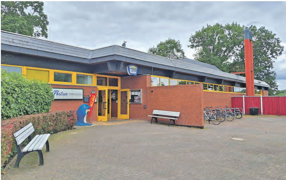
Die Preetzer Schwimmhalle wird Ende des Jahres für etwa ein halbes Jahr geschlossen. Die Technik hinter den Kulissen wird modernisiert.
