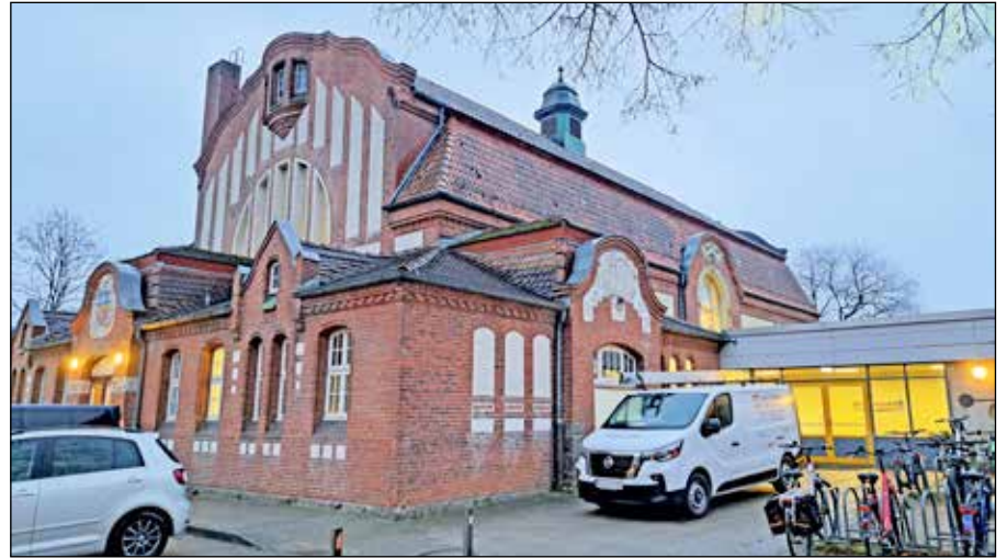
Dem Rotstift zum Opfer gefallen: Die geplante Sanierung und Umgestaltung der Alten Wilhelminenhalle ist erst einmal auf Eis gelegt. Foto: Graap
