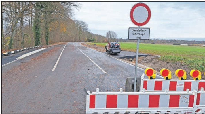
Der erste Bauabschnitt ist fertig. Die Straße zwischen Schellhorn und Sophienhof wird bis Februar wieder befahrbar sein. Foto: Graap
