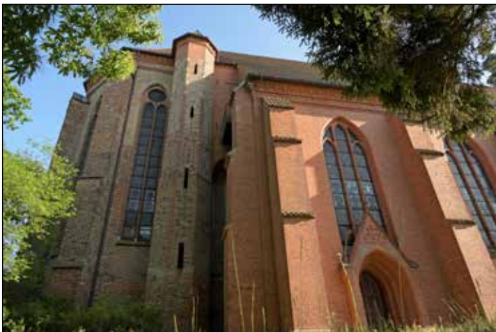
Turm an der Nordseite des Chors.
