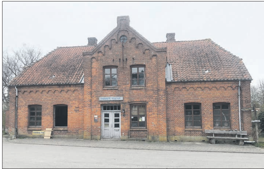
Auf den Verein Panker-Kultur e.V. wartet noch viel Arbeit, aber bald soll das historische Gebäude regelmäßig die Pforten öffnen.
