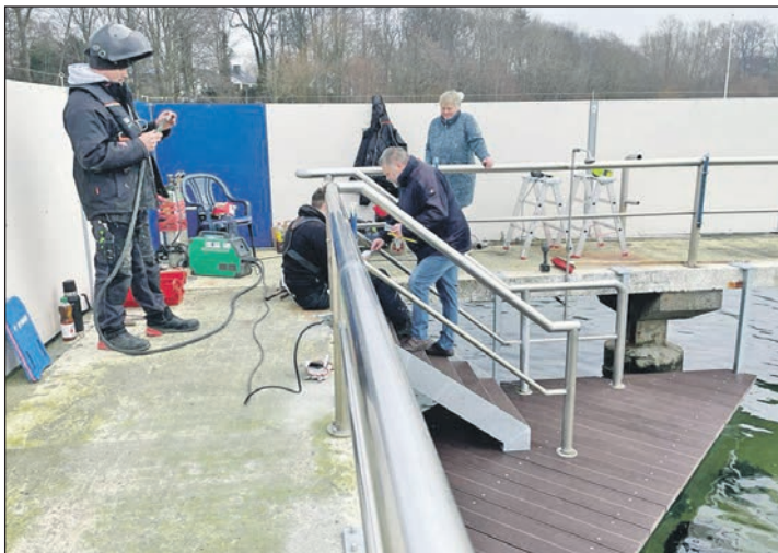
Im März wurde die zweite neue Badetreppe samt Plattform montiert.
