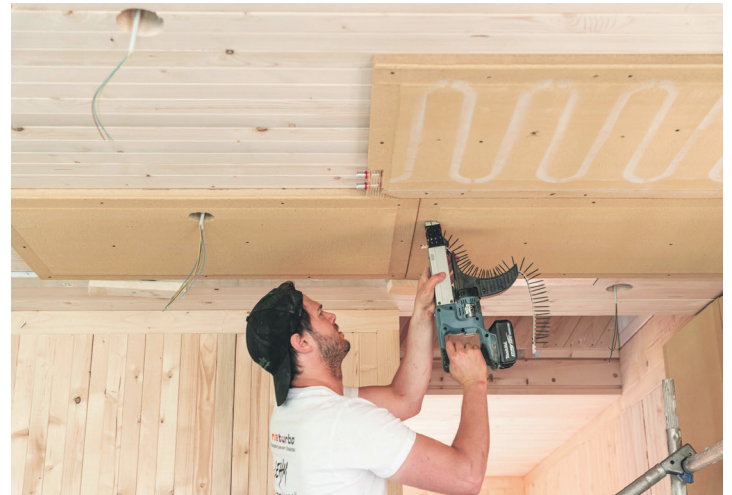
Vorgefertigte Flächenheizungselemente mit wohngesundem Lehmputz lassen sich schnell und einfach einbauen. Fotos: DJD/Naturbo
