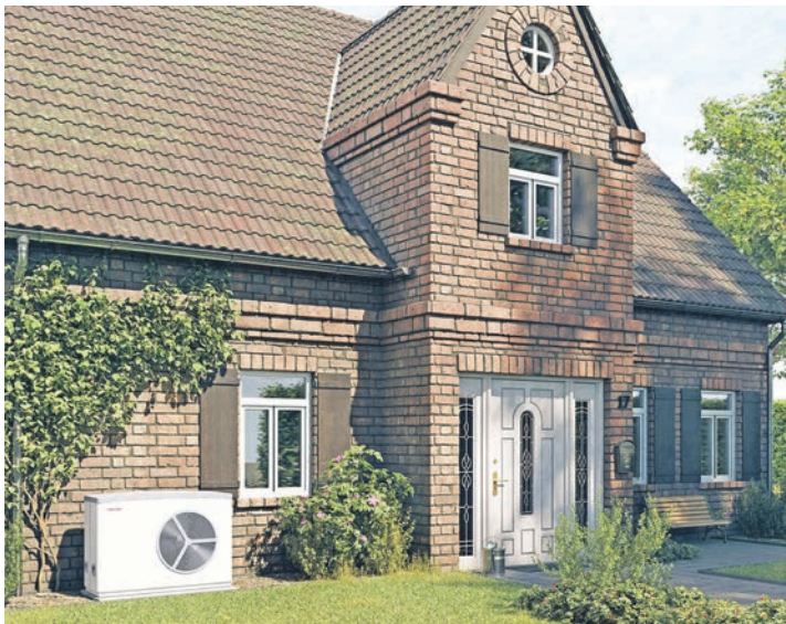
Umweltfreundlich und nachhaltig heizen: Wärmepumpen sind auch für die Modernisierung im Altbau vielfach die richtige Wahl.
