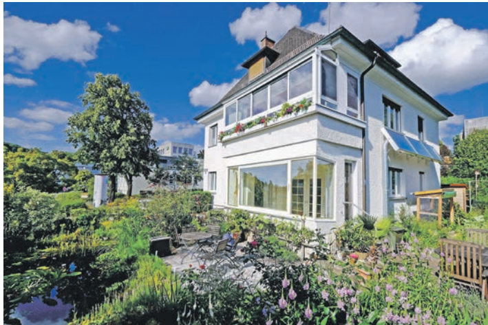
Eine Solarlüftung an der Südfassade sorgt jetzt für ein besseres Raumklima im Keller. Foto: DJD/GRAMMER Solar GmbH
