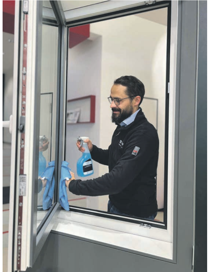
Der richtige Fensterreiniger, ideal ist ein Universal-Pflegemittel für Profile, Glas und Dichtungen sowie ein weiches Putztuch genügen, um das Fenster zu säubern.
