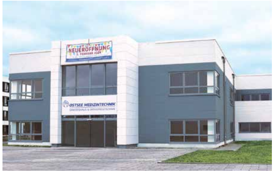
Die neue Geschäftsstelle Zentrale mit Werkstätten.
