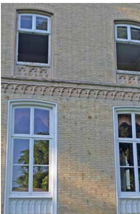
Deutlich zu sehen: oben im Bild die noch zu restaurierenden Fenster, im unteren Teil sind die Arbeiten abgeschlossen.
