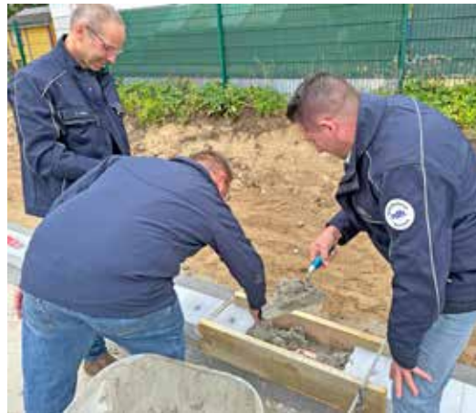
Beim Einbetonieren der mittlerweile durch einen Handwerker verlöteten und als Zeitkapsel dienenden Blechhülse im Fundament, von rechts nach links: Christian Kraft (Vorstand rdh.), Claus Hopp (Wachleiter Rettungswache Oldenburg), Jörn Haller (Teamleiter Facility der rdh.)
