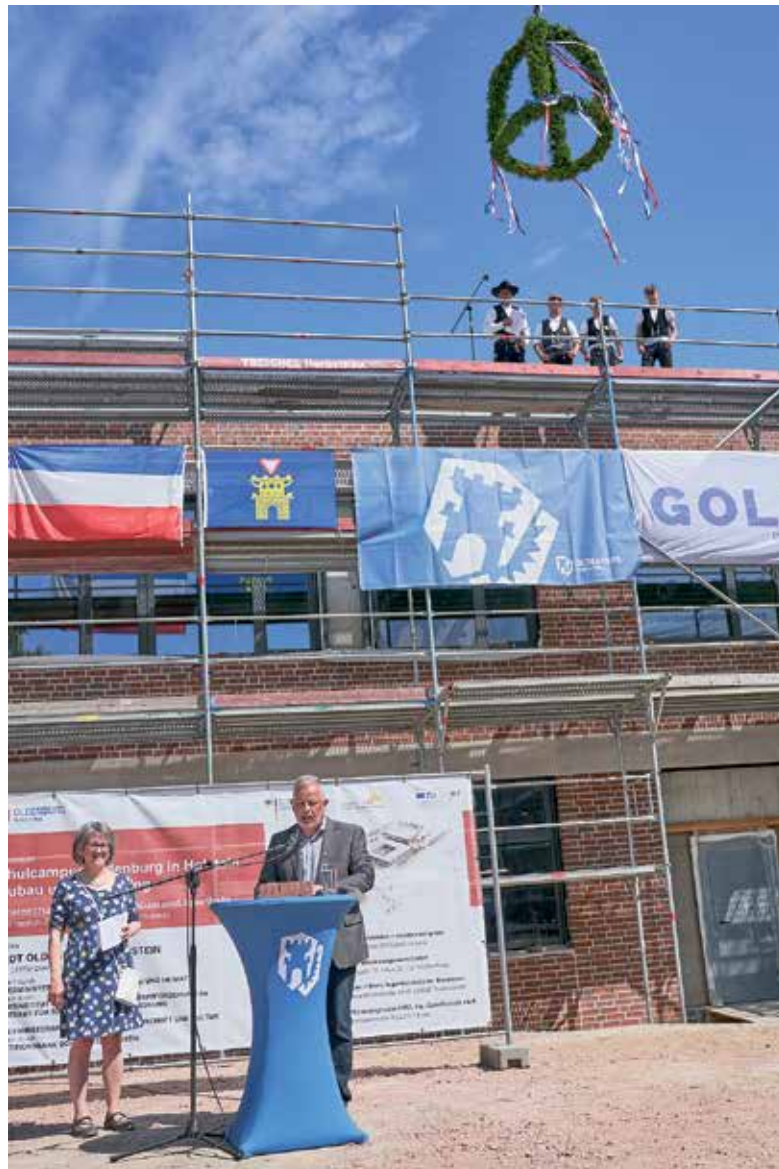
Oldenburgs Bürgervorsteherin Susanne Knees und Bürgermeister Jörg Saba begrüßten die Gäste herzlich zum Richtfest und freuen sich auf den Richtspruch, der einen wichtigen Bauabschnitt besiegelte. Foto: Christian Wese
