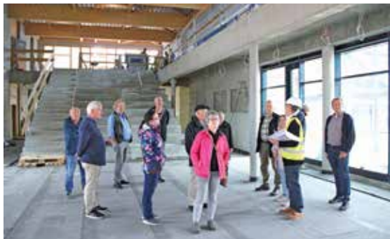
Baubegehung des neuen Schulcampus
