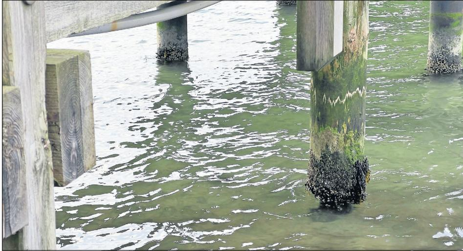
Die Seebrücke am Strandbad in Neustadt zeigt an mindestens zwei Pfosten erhebliche Schäden auf. Die Bereiche, die sich sonst unterhalb der Wasseroberfläche befinden, sind schätzungsweise um mehr als die Hälfte reduziert.
