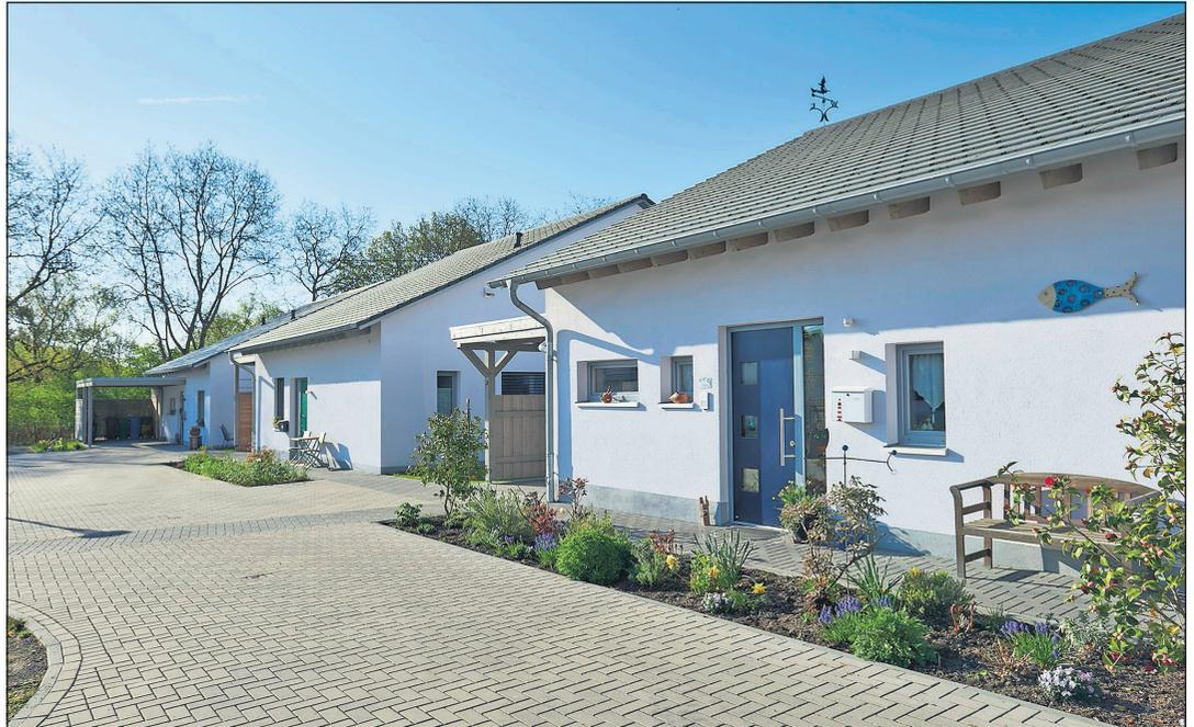
**Massive Einfamilienhäuser aus Leichtbeton-Mauerwerk: Rein mineralische Leichtbeton-Wände gelten als „nicht brennbar“ und vermindern die Verbreitung von Rauchgasen.(Foto: DJD/KLB Klimaleichtblock)**
