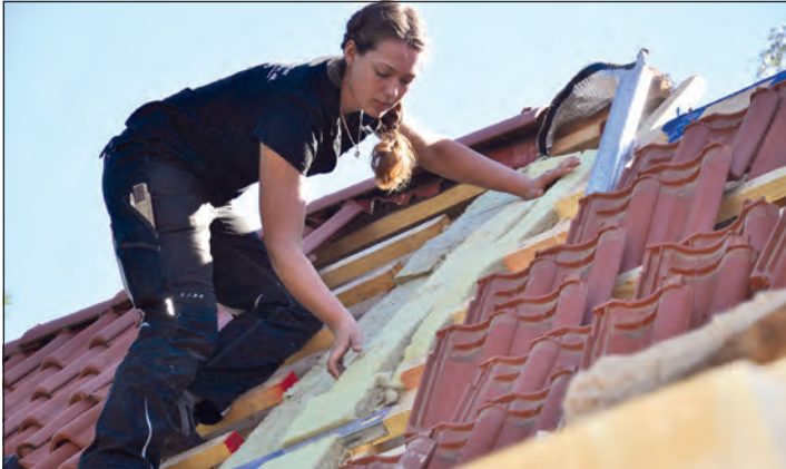
Dachdeckerinnen sind auf dem Vormarsch: schweres Tragen ist out, das übernehmen Lastenaufzüge. (Foto: ZVDH/akz-o)
