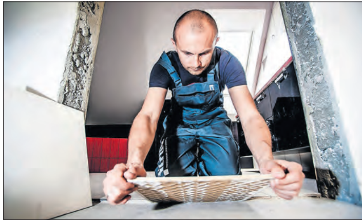
Beim Verlegen von Fliesen ist Genauigkeit sehr wichtig.
