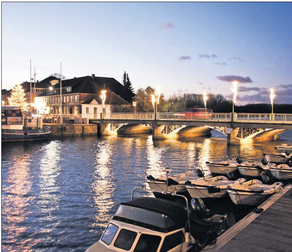
Die Hafenheimat-Beleuchtung erleuchtet die Hafenbrücke und die Innenstadt.
